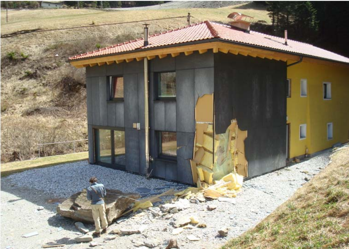
Bild 3: Schadensereignis in Tirol 2011, Sturzblock mit einer Kubatur von ca. 2 m 3
